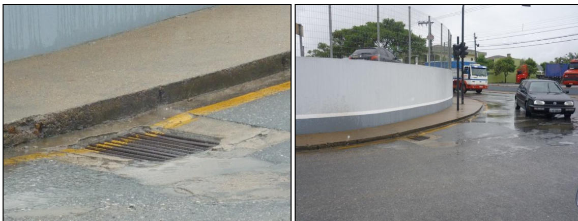
Figura 5: Imagem de boca de lobo soldada implantada em Jaraguá do Sul (Foto: Dezembro/2010).
